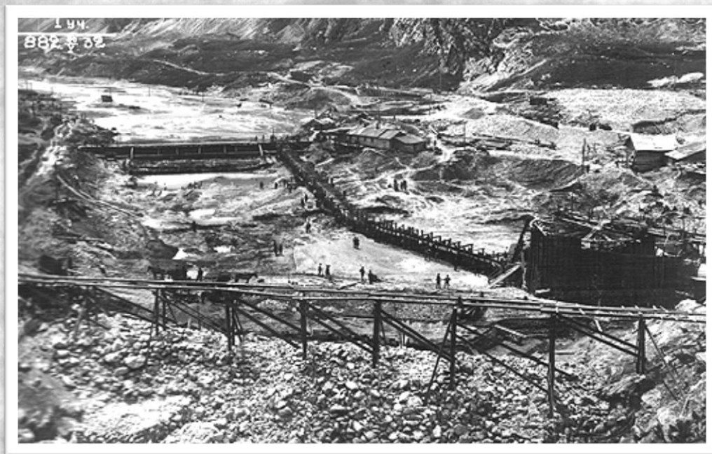
строительство Гизельдонской ГЭС, 30-е гг. XX века
